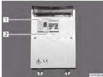
Bild 119 230-V-Sicherungskasten mit Leitungsschutzschalter und FI-Schalter
